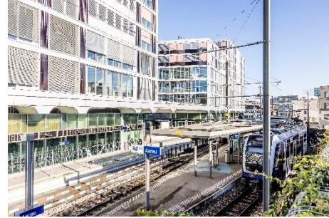
Im Dezember 2023 nahm Aargau Verkehr den Neubau am Bahnhof Aarau in Betrieb. Darin befinden sich die Direktion, die Zugleitstelle und ein neues Reisezentrum.
